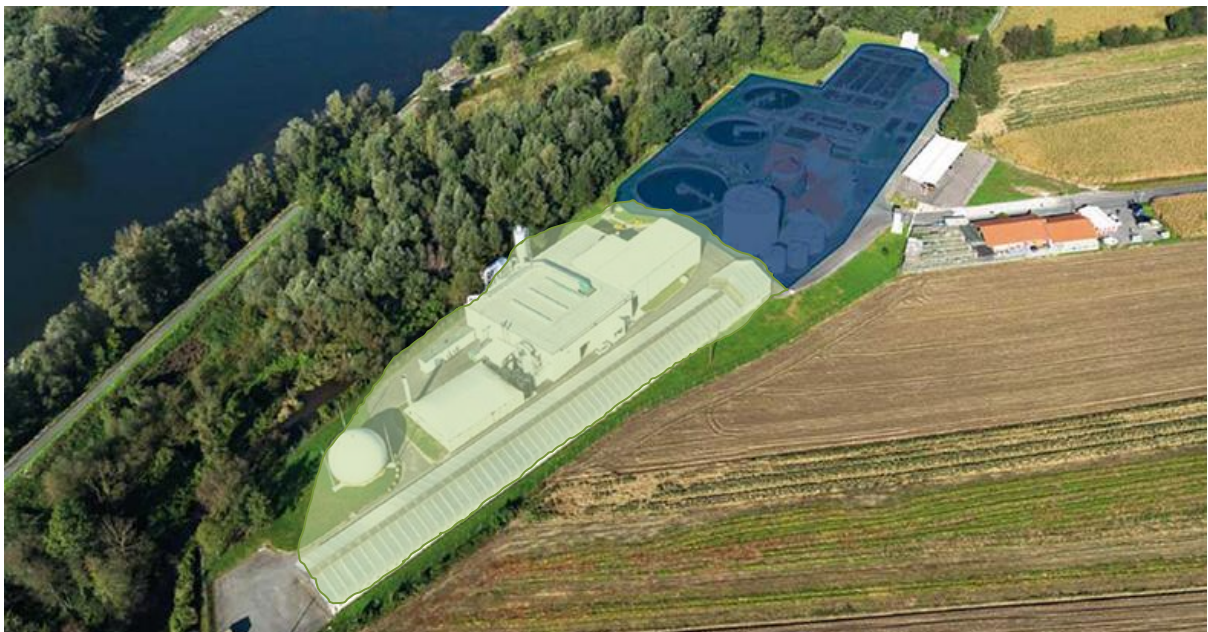
Abbildung 11: Kläranlage (blau) sowie Gasaufbereitung und Klärschlamm-trocknung (grün) © Umweltkompetenzzentrum LeibnitzerfeldSüd
